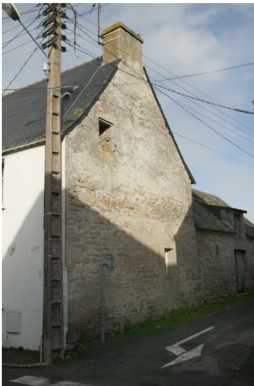
Vue du pignon et de la dépendance.
