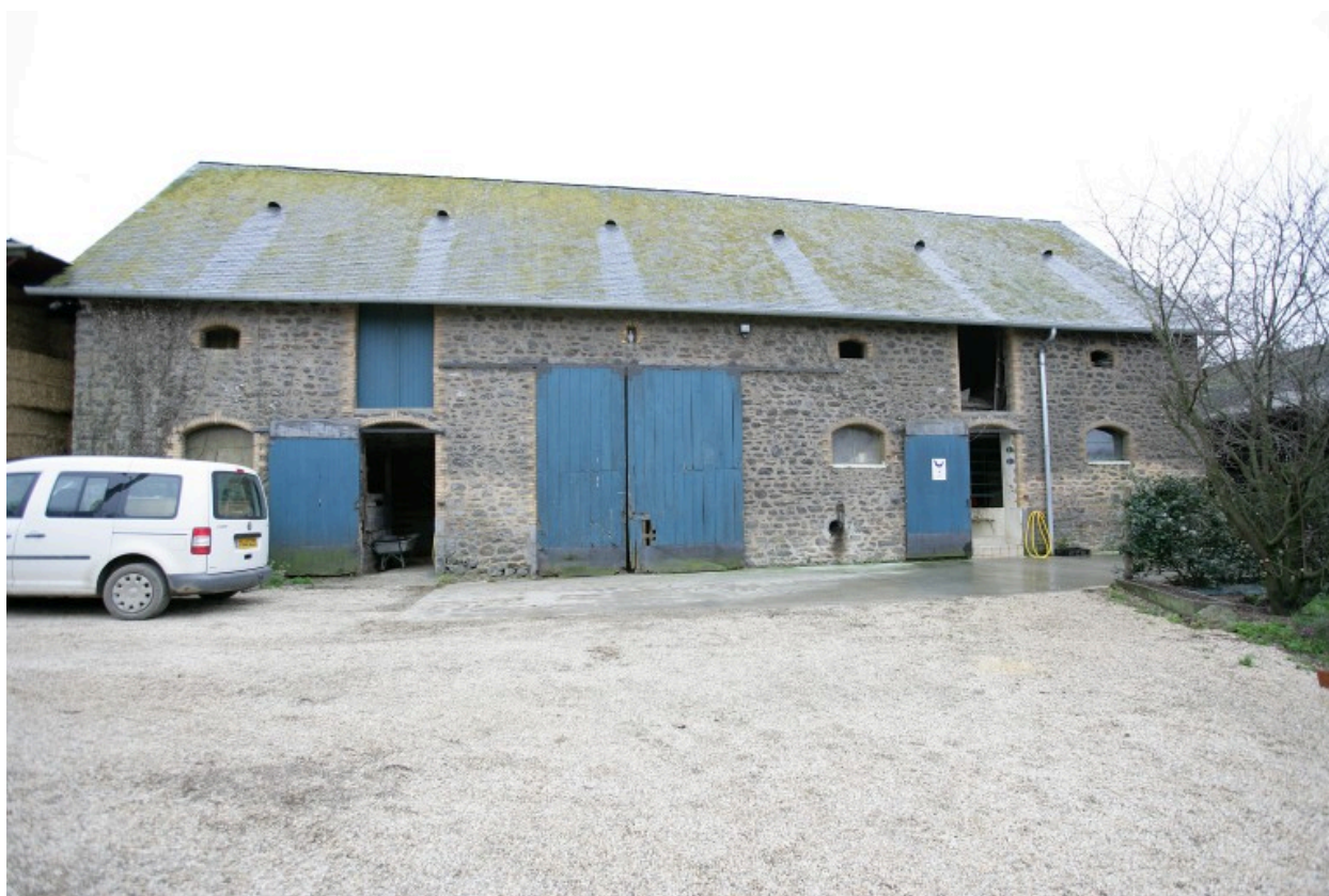
L'étable-grange vue depuis la cour au nord-est.
