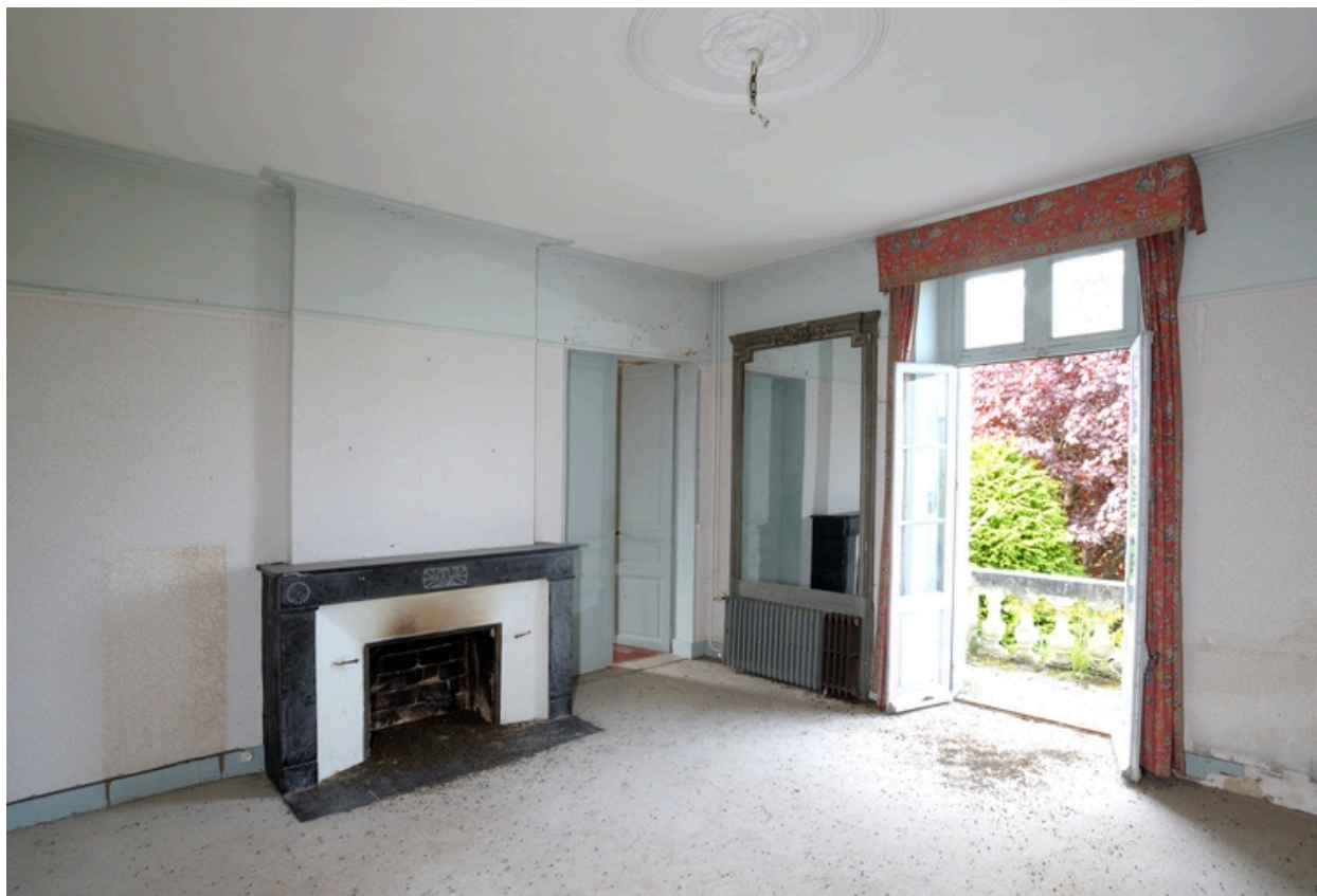
Corps ouest, intérieur, rez-de-chaussée : salle nord-ouest à cheminée du XIXe siècle à décor de fleurons et rinceaux.
