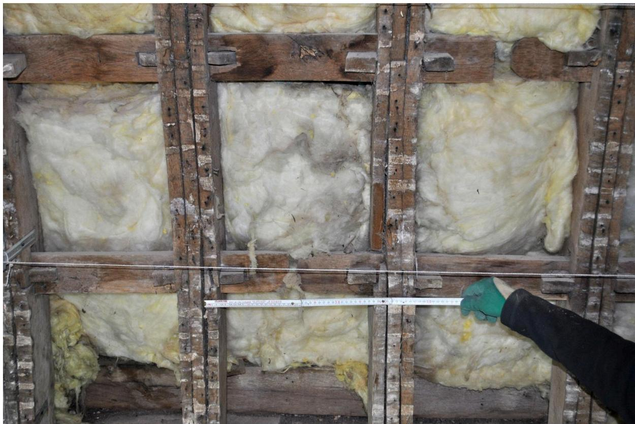
Vue de détail de la charpente, montrant l'assemblage des petits bois des fermes.
