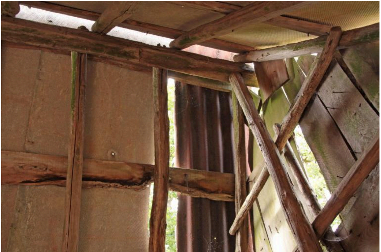
Le hangar 2 : faîtage et chevrons.
