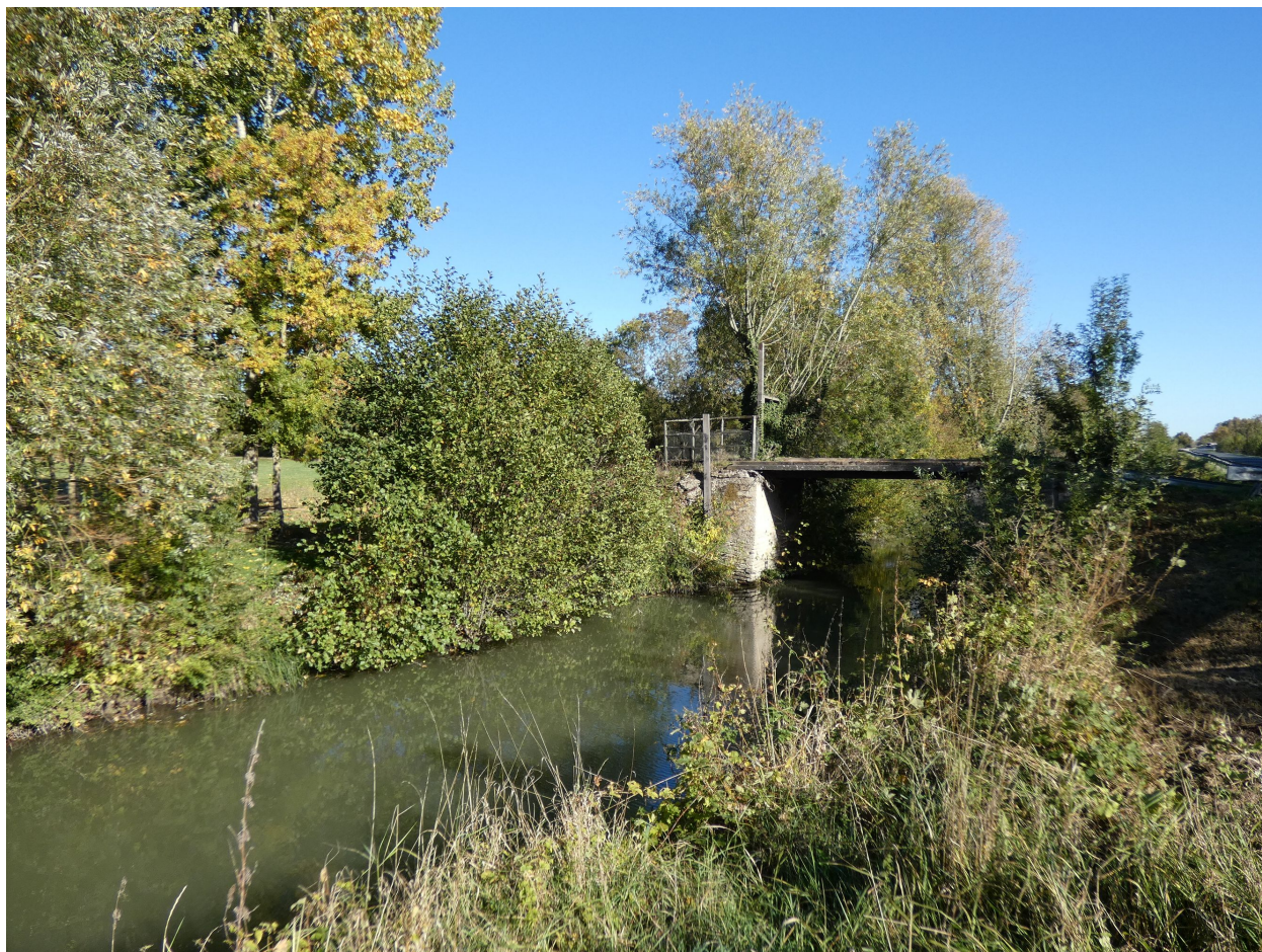
Une des passerelles franchissant le canal, près de la Grande Bernegoue, vue depuis l'ouest.
