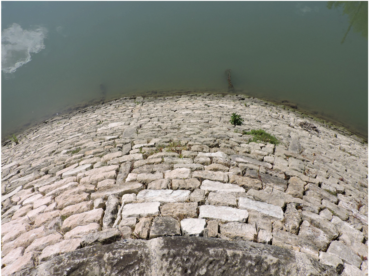
Détail du musoir à l'extrémité sud de l'îlot et de sa maçonnerie.
