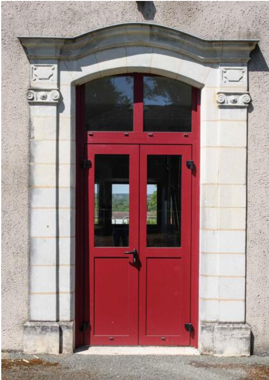
Façade sud. Détail de la porte d'entrée.
