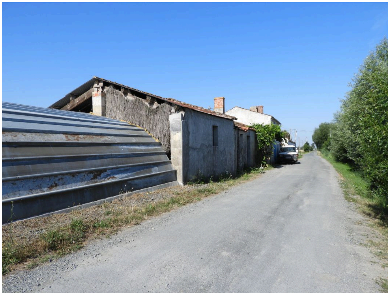
La ferme vue depuis l'est ; au premier rang, l'ancien hangar.
