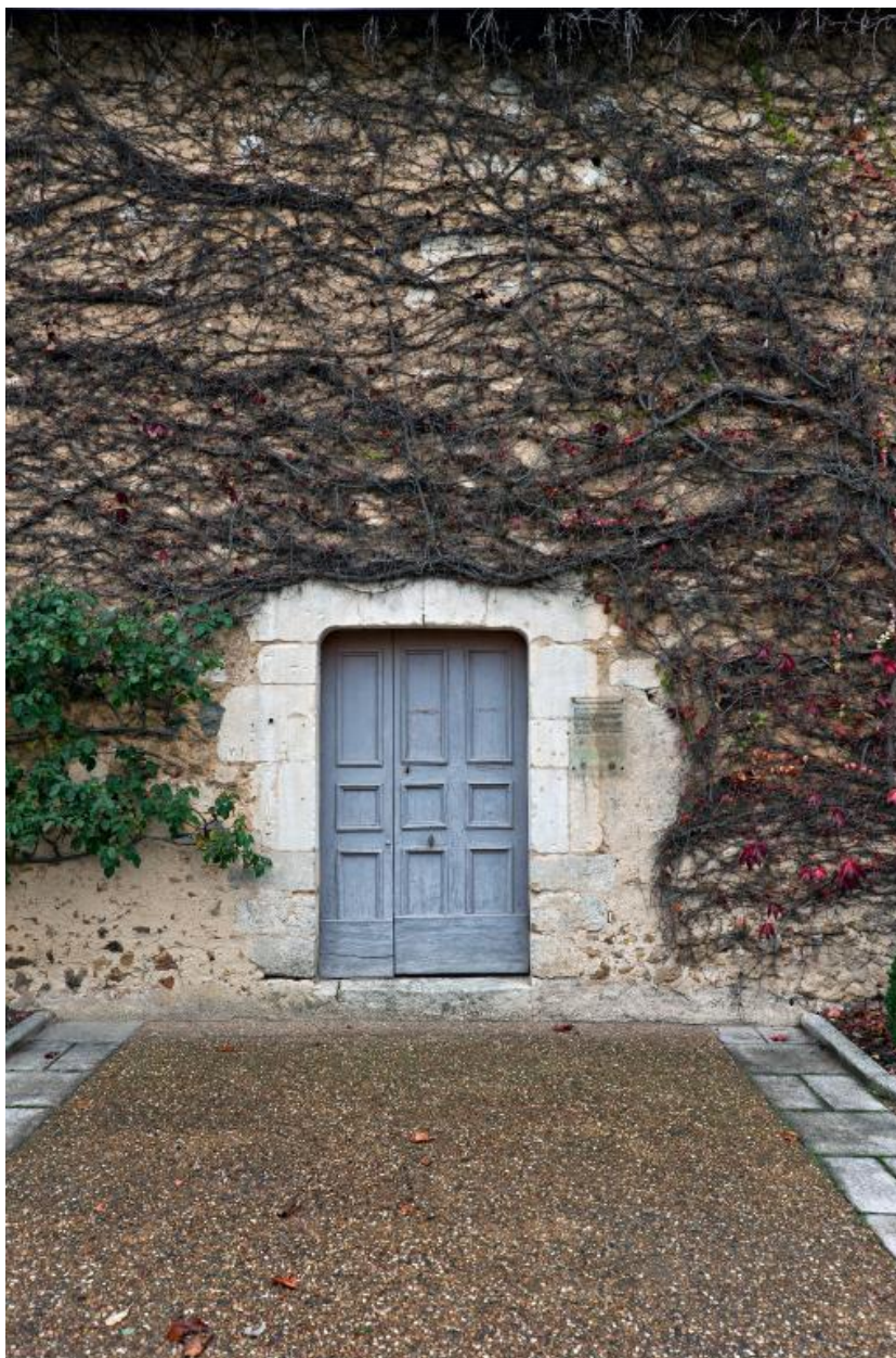
Mur sud de l'église : porte.
