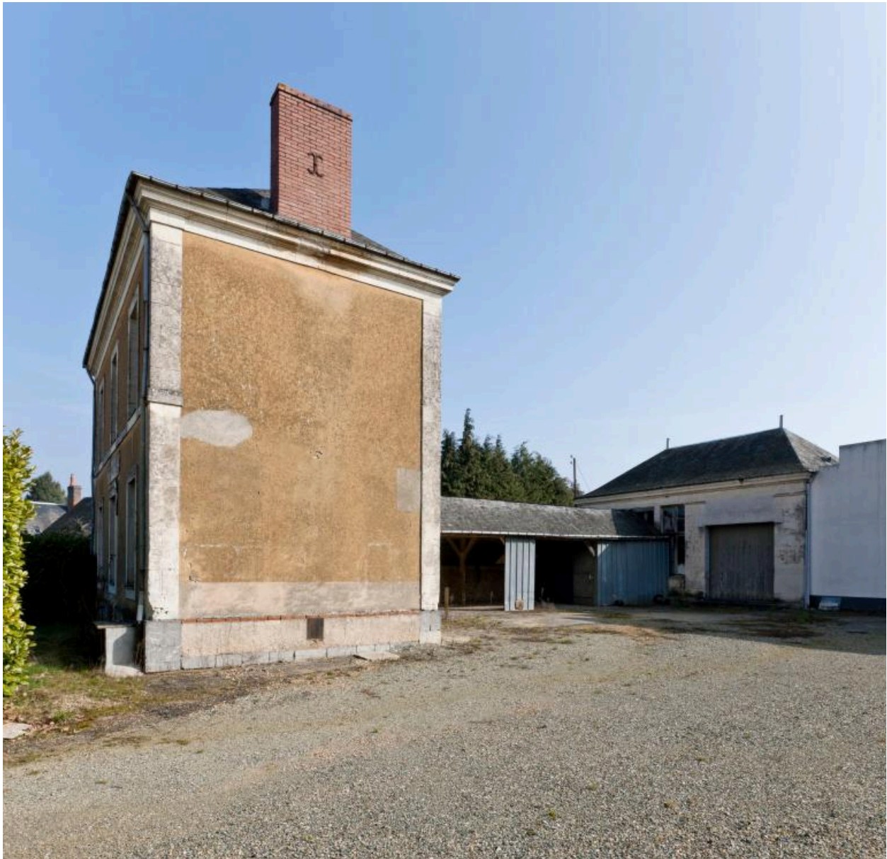
Vue d'ensemble : logement de l'instituteur au premier plan, préau puis classe au fond.
