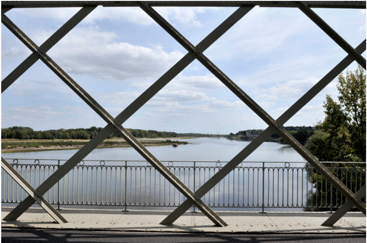
Treillis double de la charpente métallique (détail)
