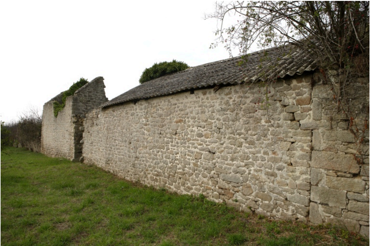
Vue des bâtiments est depuis le nord-est.
