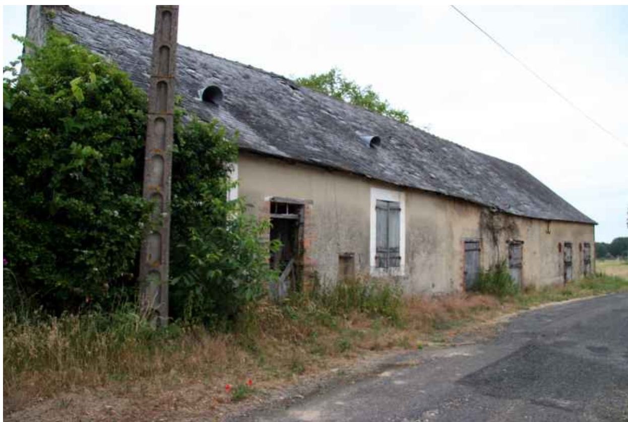
Maison 2 : façade antérieure.
