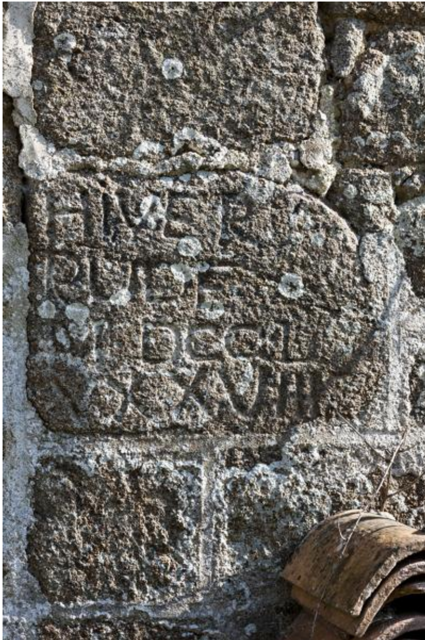
Inscriptions sur l'encadrement de la porte du logis gauche de l'alignement sud du village (2023 ZC 21) : "HIVER RUDE 1788".
