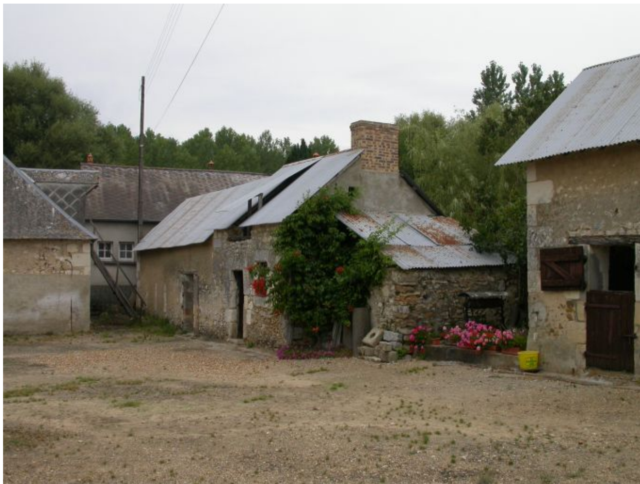
Buanderie : façade rehaussée.
