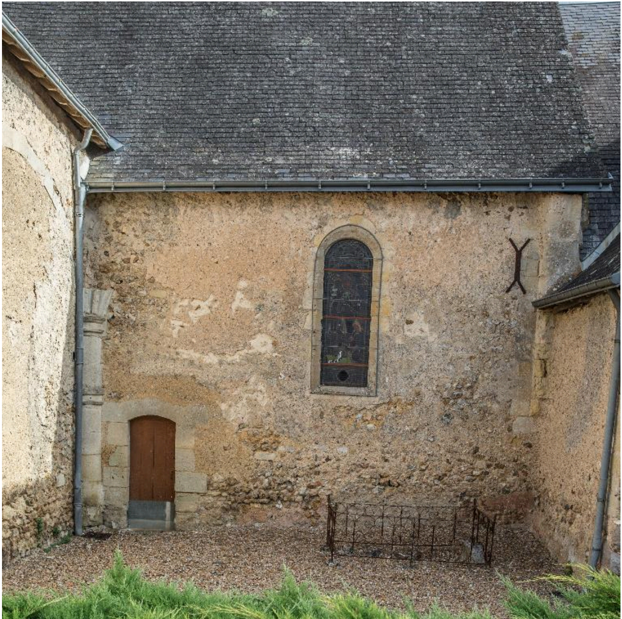
Nef, façade sud (emplacement chapelle non construite).
