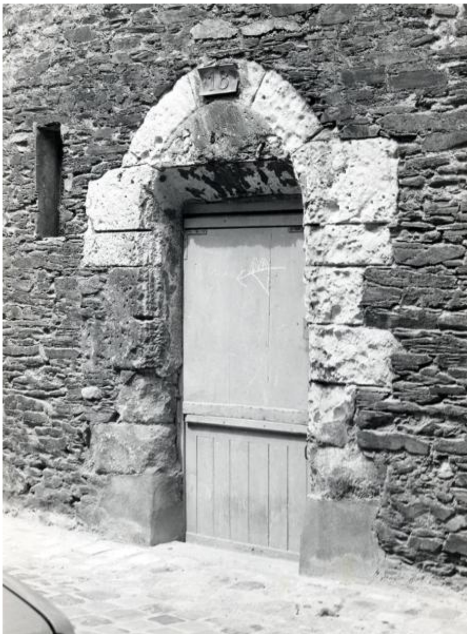
Façade sur rue (est) de la demeure (16 à 20 rue de la Censerie), étage de soubassement.
