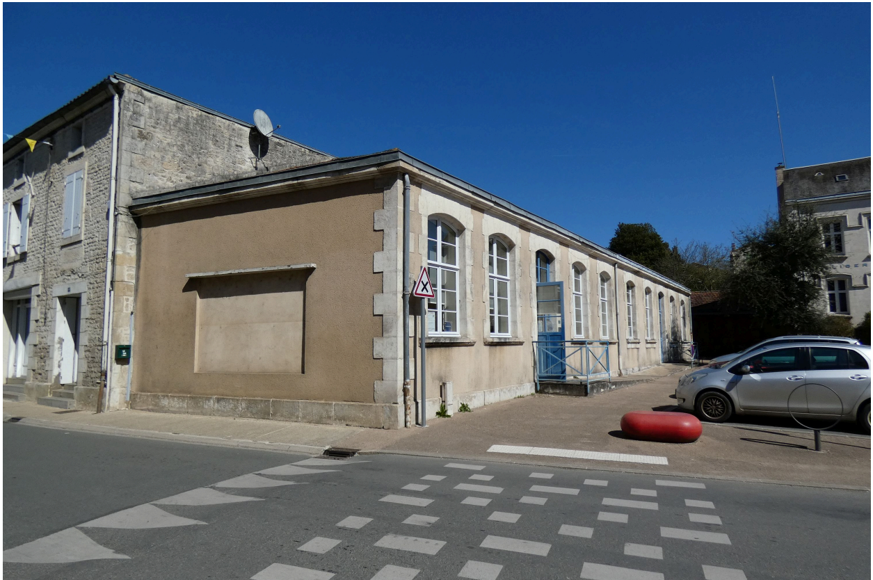
Le bâtiment de classes vu depuis le sud-ouest.
