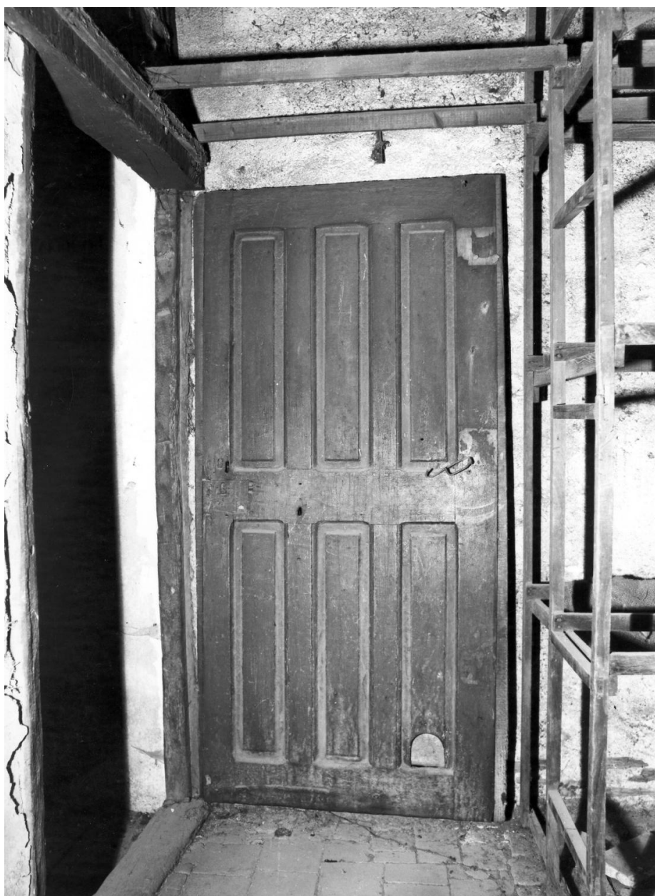
Porte de l'étage de comble, mur postérieur.
