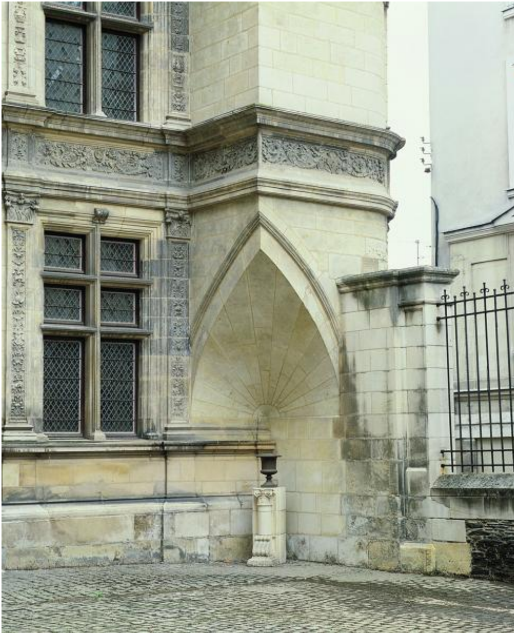
Corps de logis droit : façade sur la rue de l'Espine.
