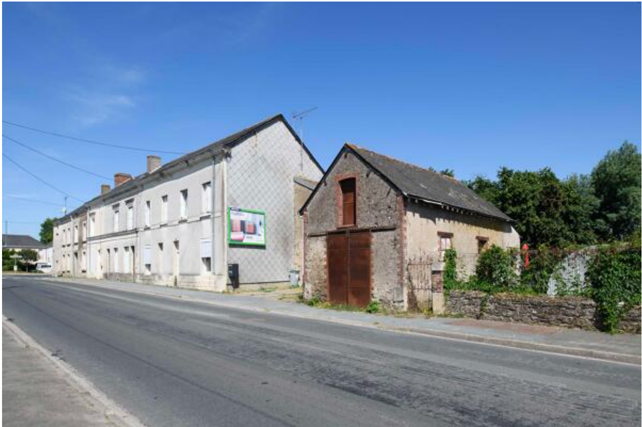
Vue de la rue d'Anjou depuis l'est en direction de l'église.
