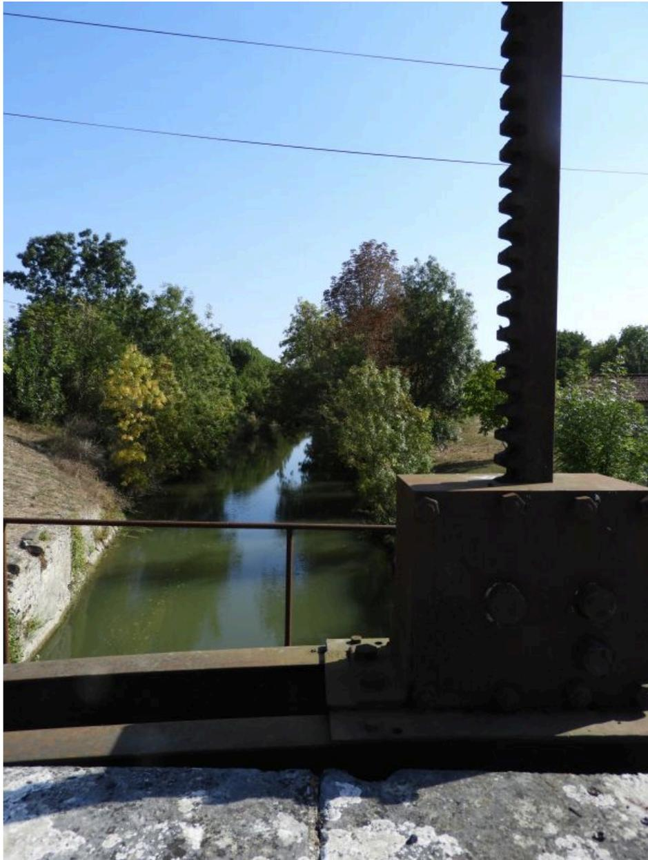
Le canal de Vix en amont de l'aqueduc vu depuis le pont qui franchit celui-ci, avec le cric à crémaillère pour la manoeuvre du barrage.
