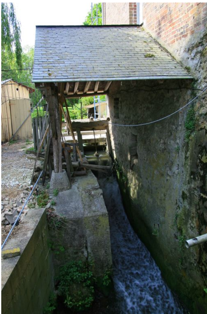
Emplacement de l'ancienne roue du moulin.
