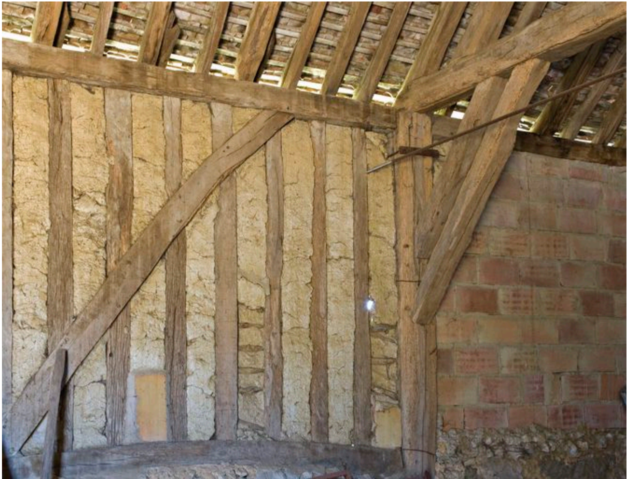
Détail de l'élévation postérieure de la grange
