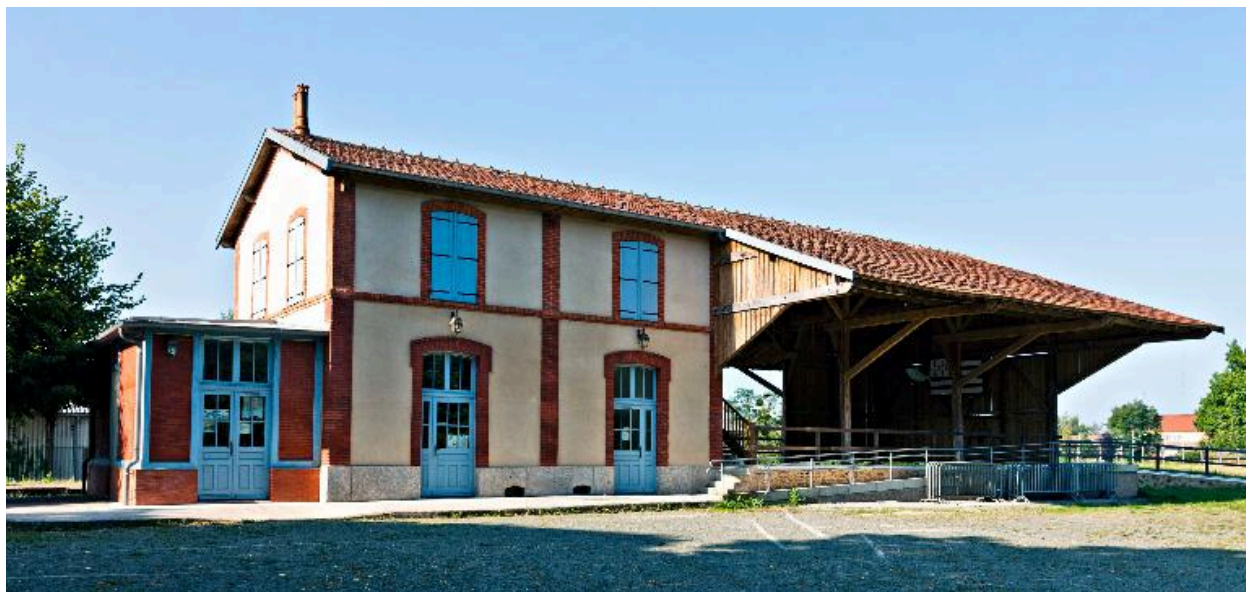
Elévation postérieure de la gare. A gauche, la salle d'attente du duc de La Rochefoucauld.
