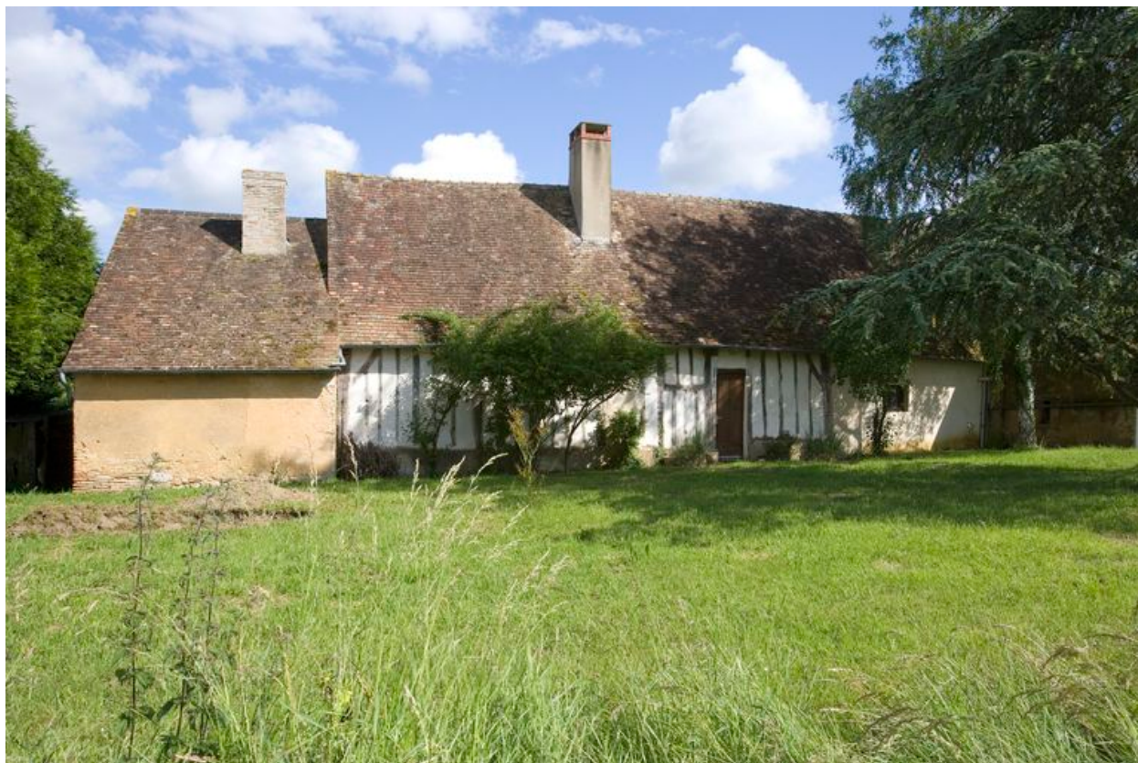
Élévation postérieure du logis.
