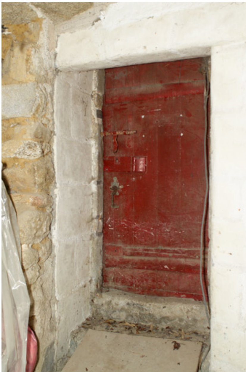
Escalier en vis, rez-de-chaussée, porte nord.
