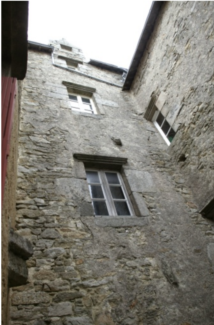
Mur sud de la tour d'escalier avec travée de fenêtres.
