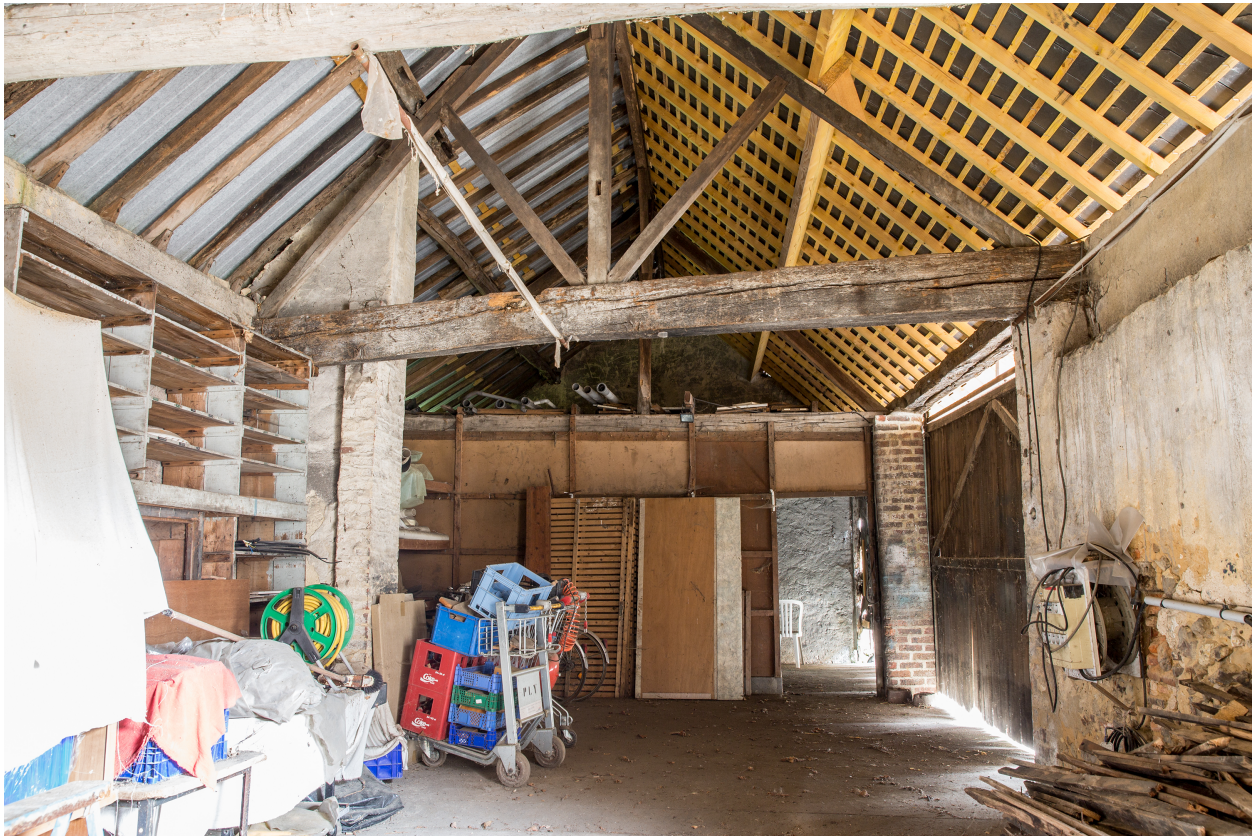
L'intérieur du bâtiment de dépendance.
