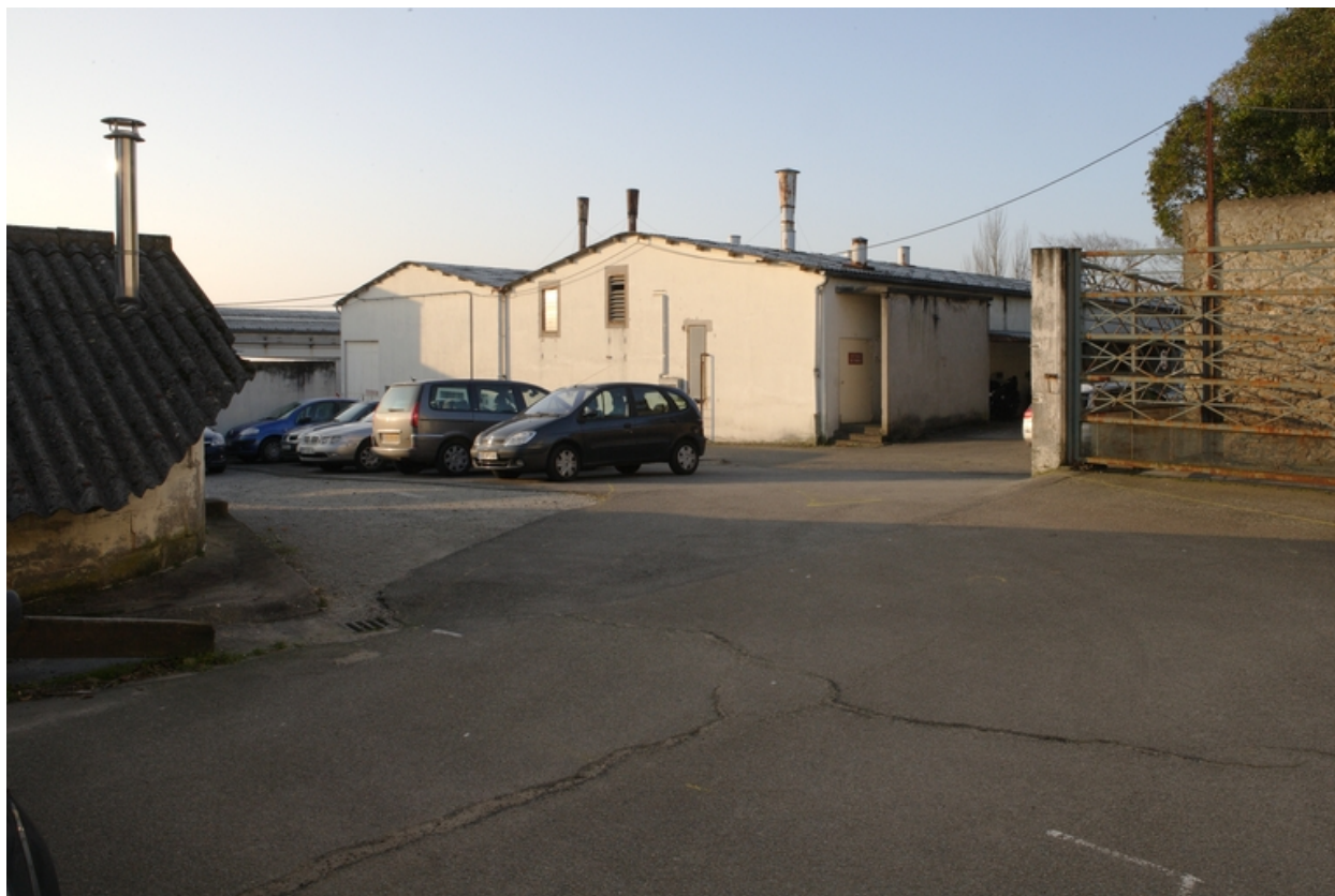
Atelier de fabrication d'encre 3 et entrée nord.
