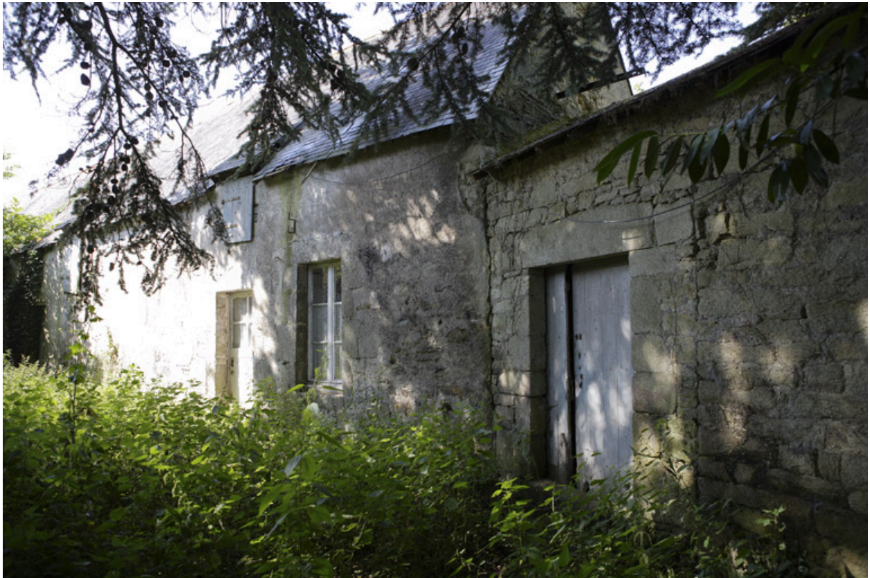
Communs. Façade ouest.
