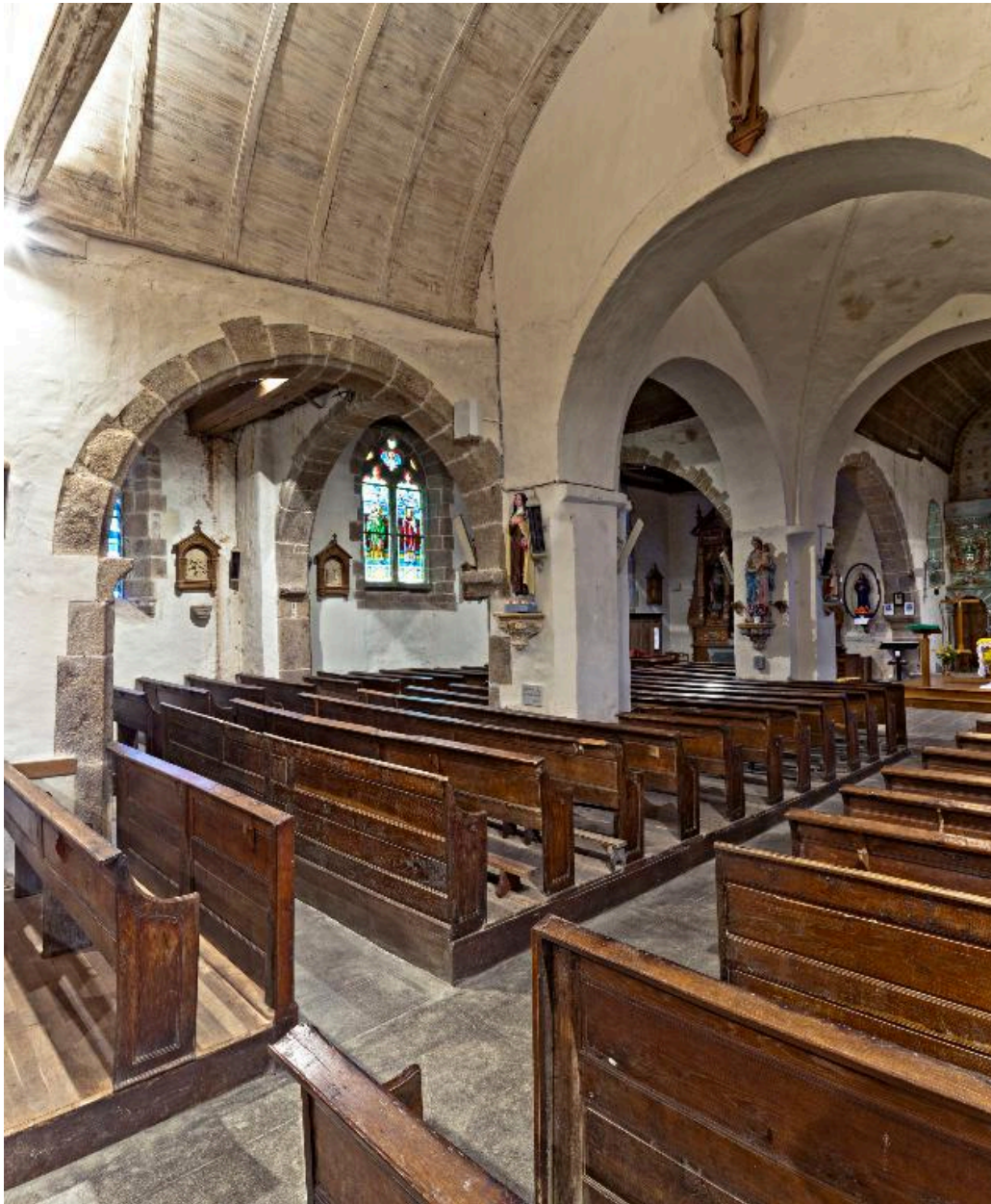
Les chapelles nord vues depuis la nef. Au premier plan, la chapelle nord-ouest.
