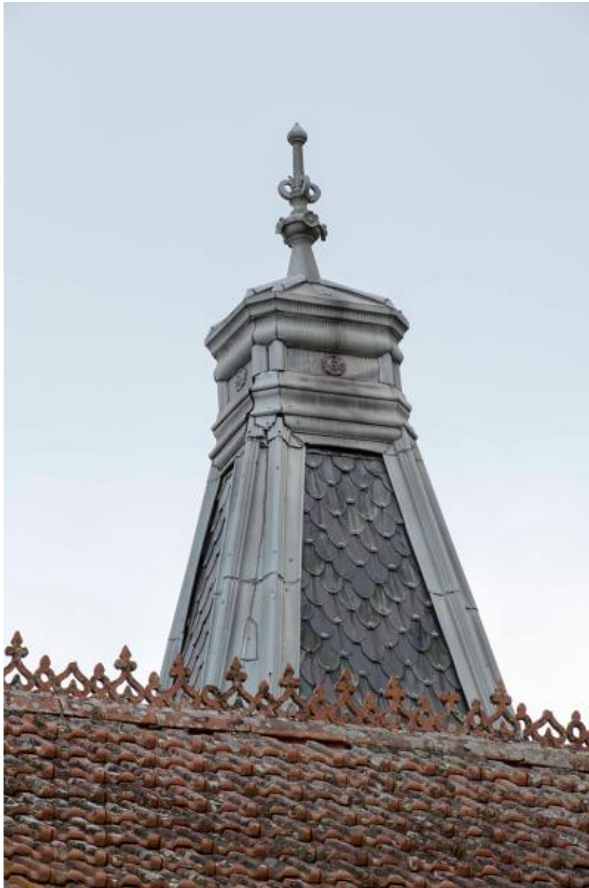
Détail du toit polygonal en ardoises polychromes.
