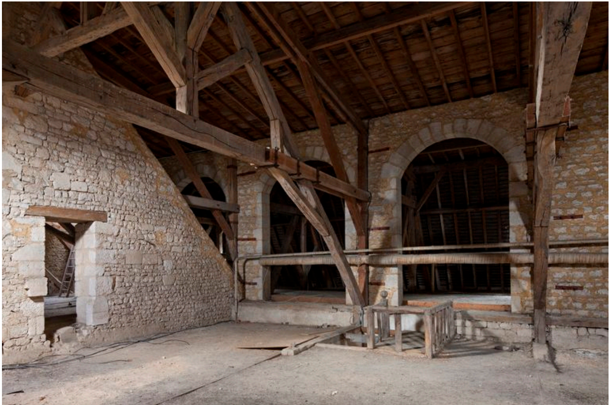
Charpente du bâtiment est. Vue prise de la partie située au-dessus de la salle du Conseil. Sur la droite, la charpente de la bibliothèque, surmontant l'aile est du cloître.
