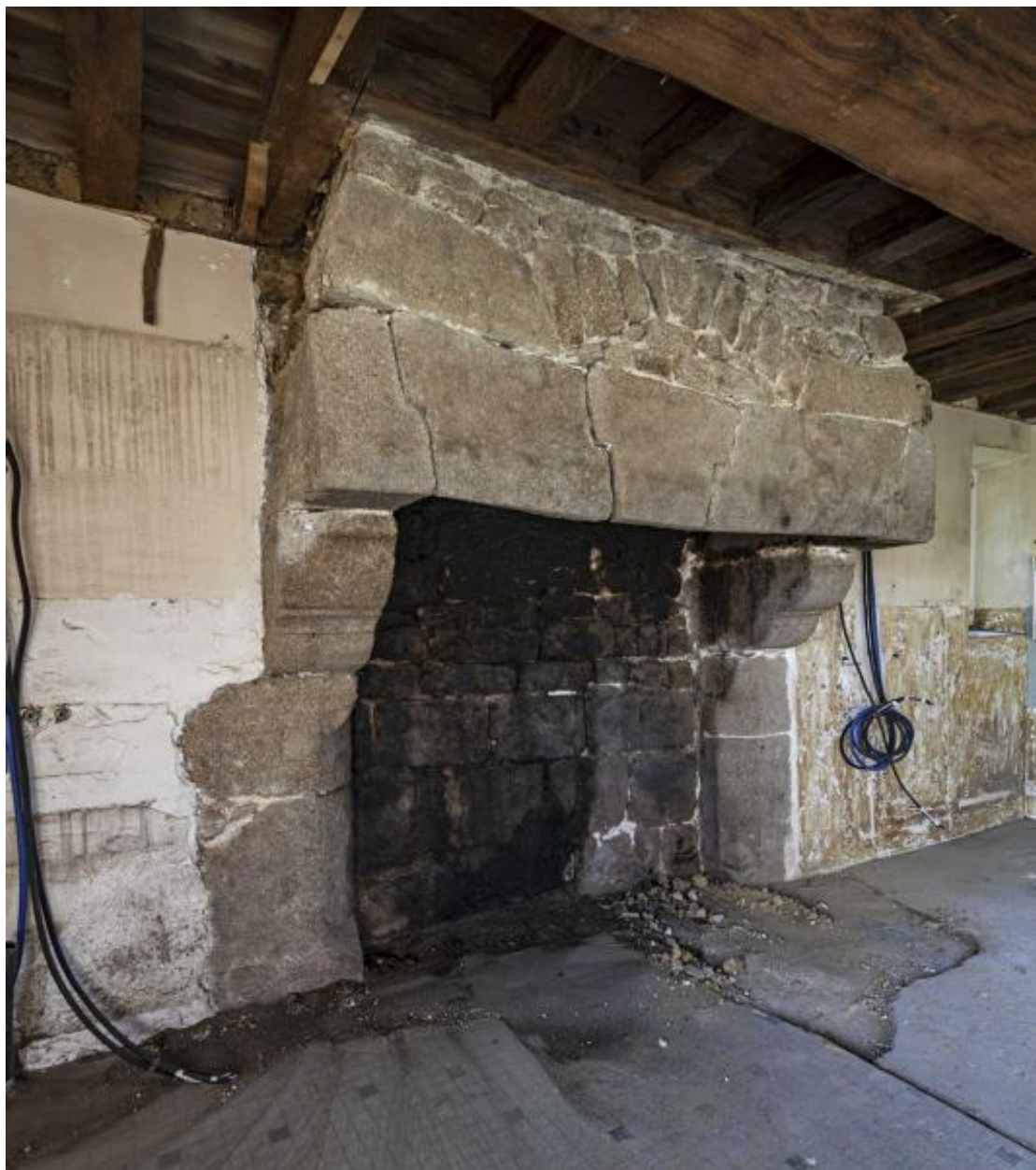
Ferme occidentale, logis central, cheminée.
