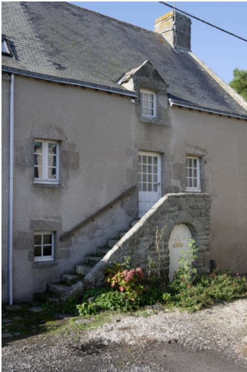
Vue du logement ouest.
