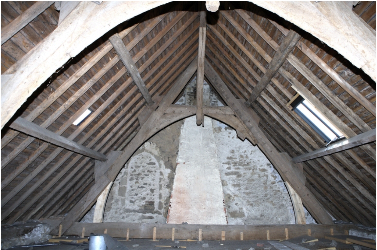
Vue d'ensemble de la charpente.
