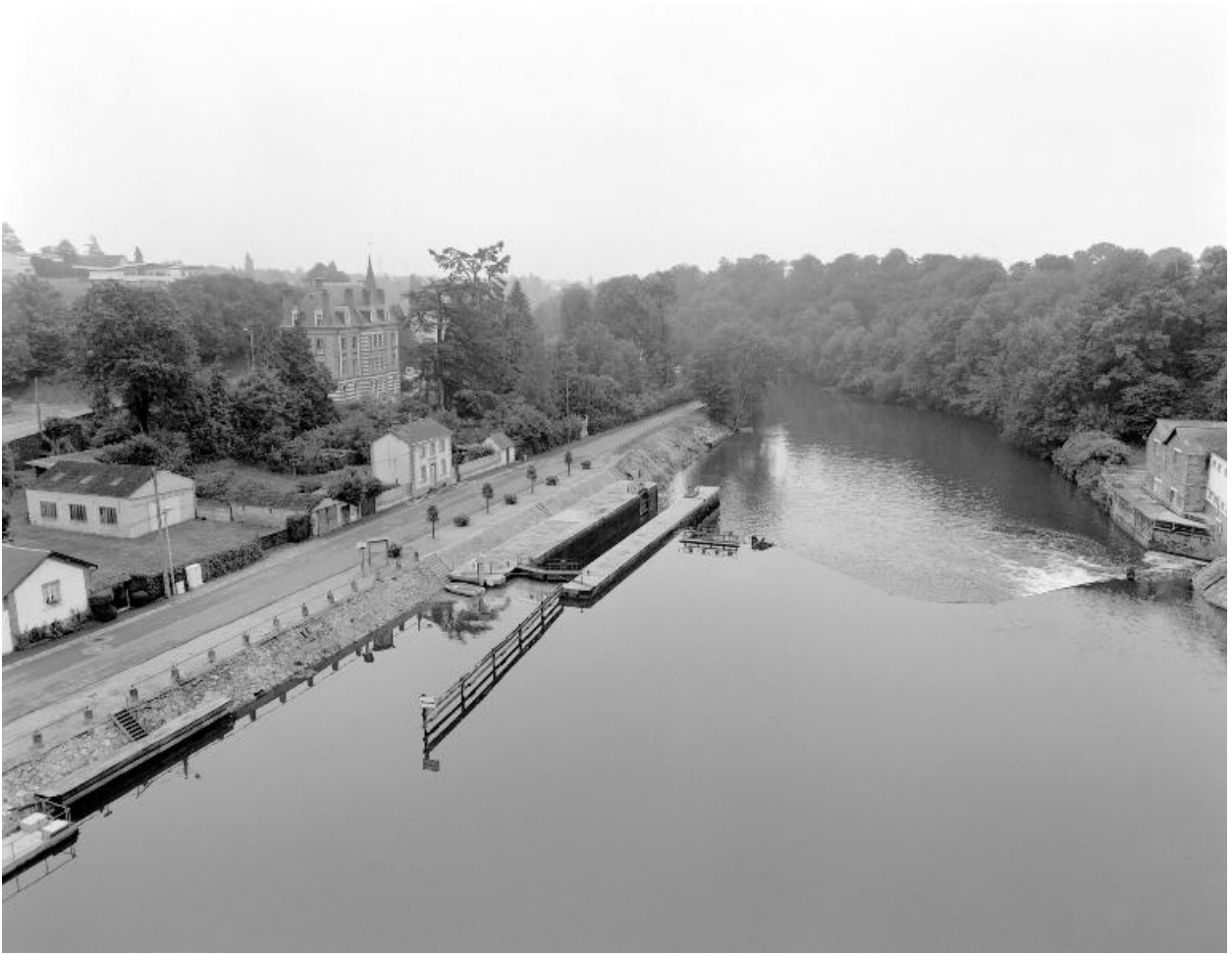
La maison éclusière, l'écluse et le barrage vus depuis le viaduc.
