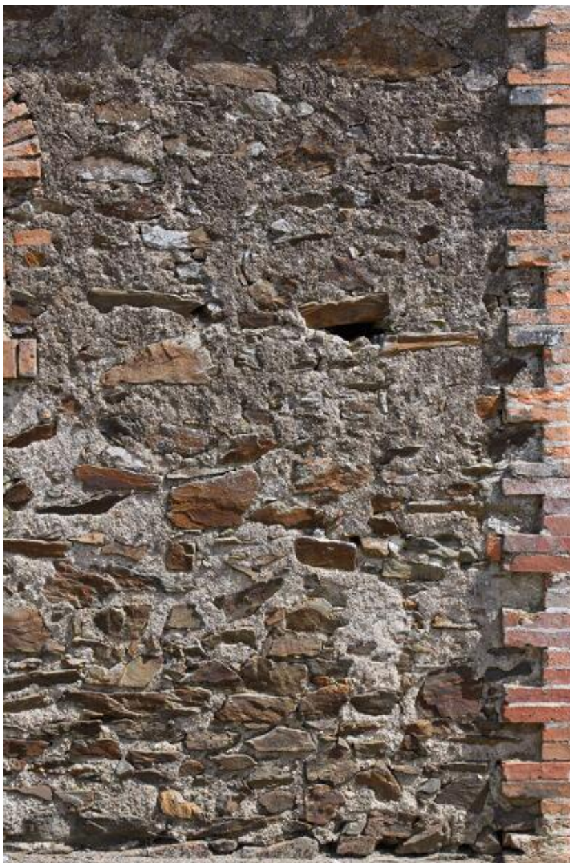
Façade ouest. Détail de la maçonnerie en moellons et du chaîne d'angle en brique.
