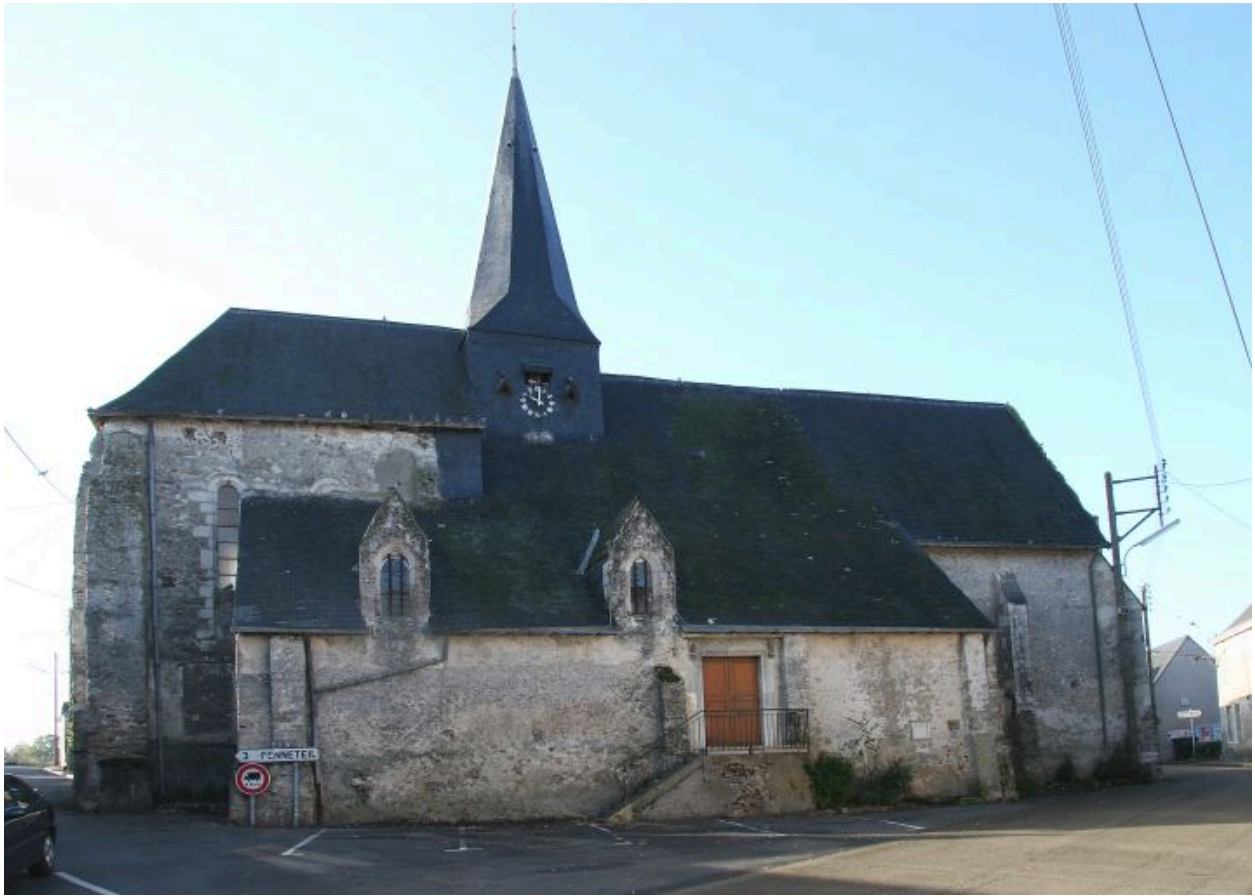
Vue de volume prise du nord.
