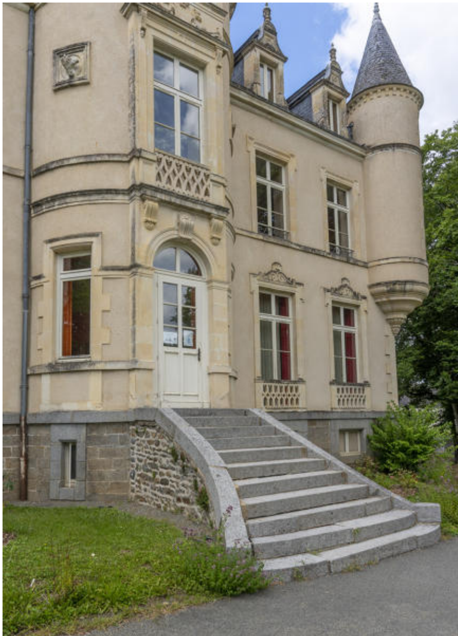
Le perron et l'avant-corps central en forme de tour.
