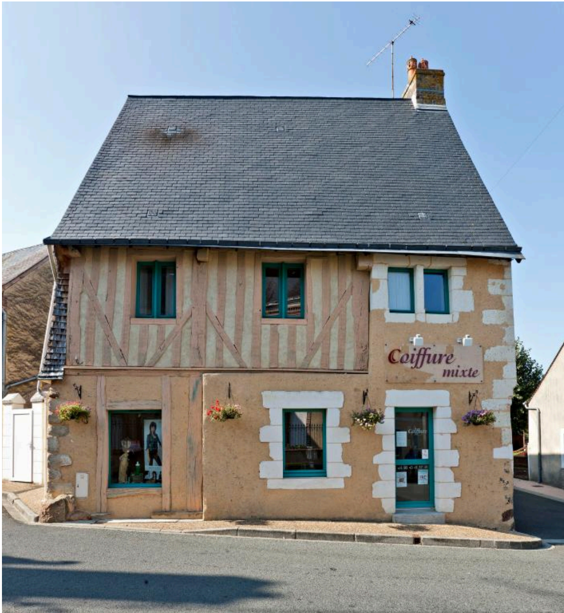
Maison du Pilier Vert : façade sur rue.
