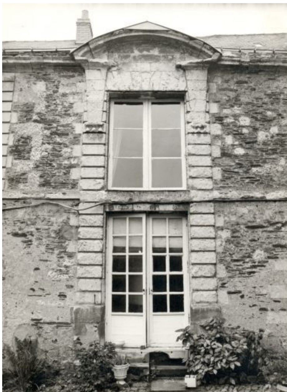
Aile droite sur cour, travée droite.
