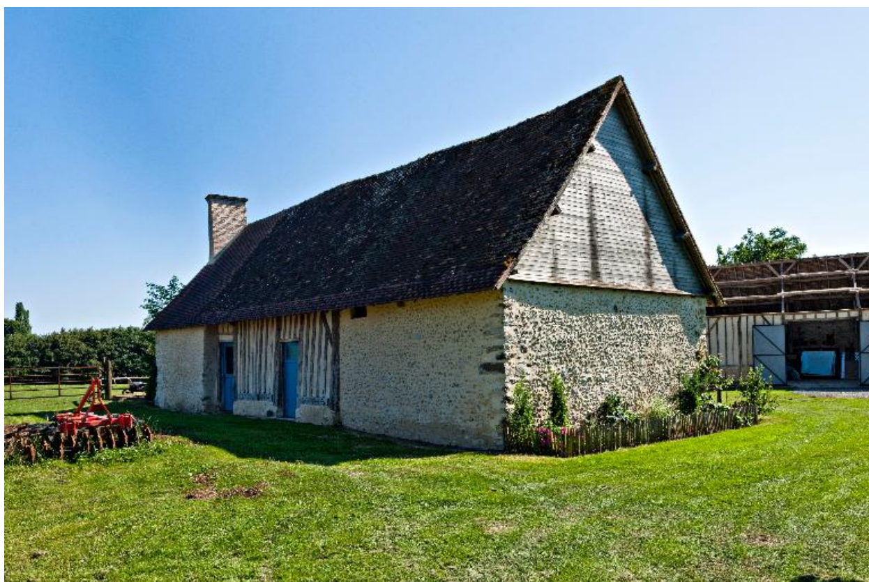
Elévation postérieure en maçonnerie de moellons et en pan-de-bois du logement de La Plumardière II.
