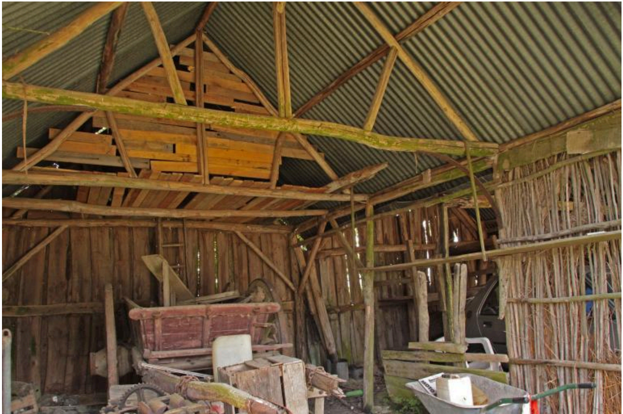
Le hangar 2 : structure de bois.
