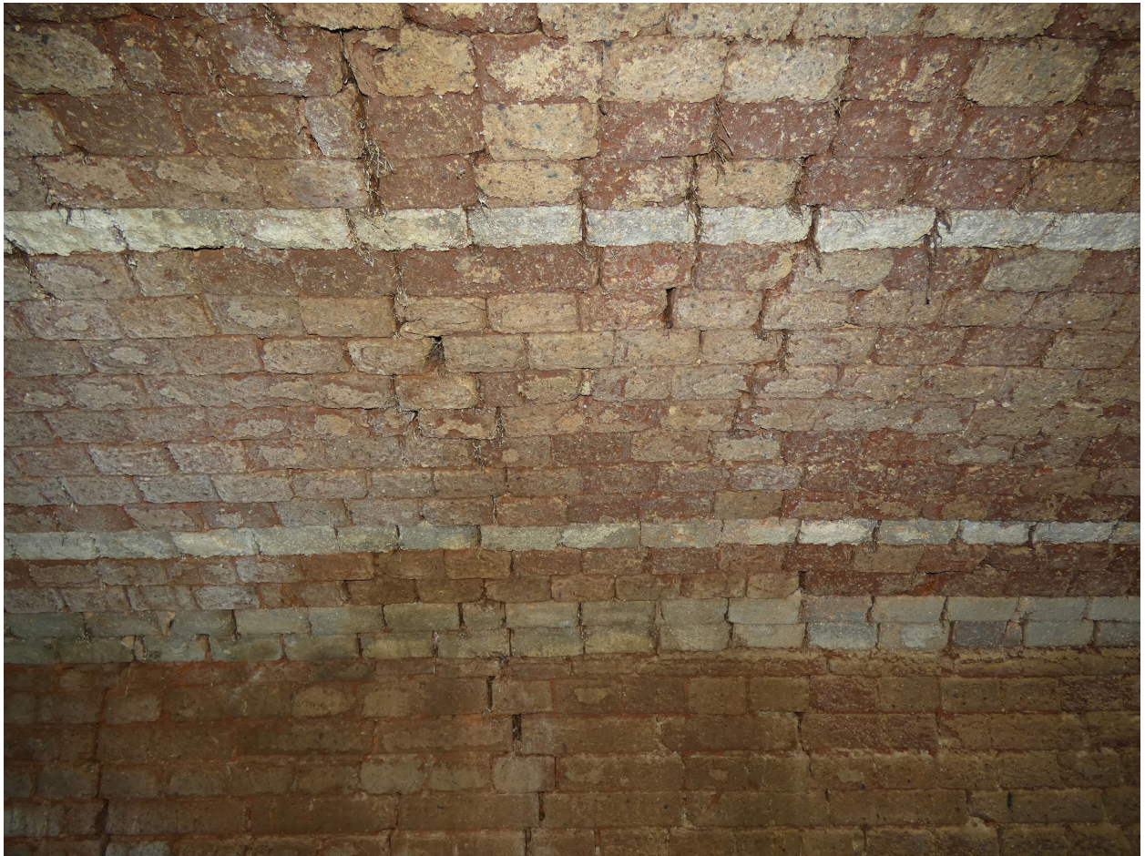
La voûte en parement de briques réfractaires du premier four.
