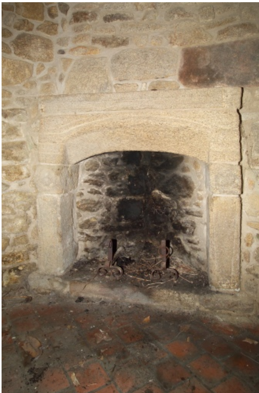
Cheminée du bâtiment cadastré AK 4.
