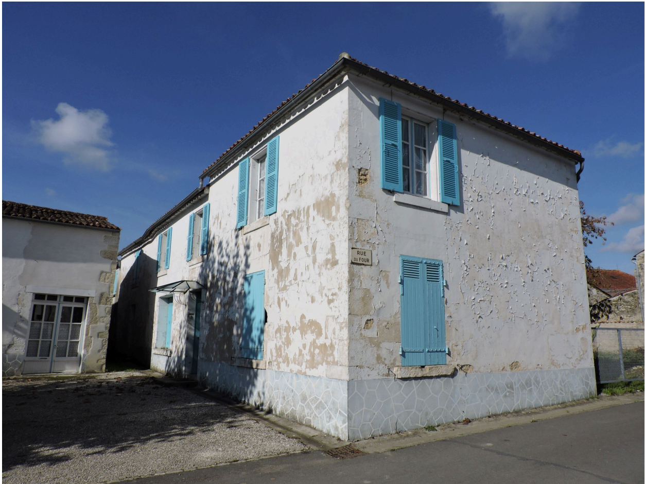
La maison vue depuis le sud-est.
