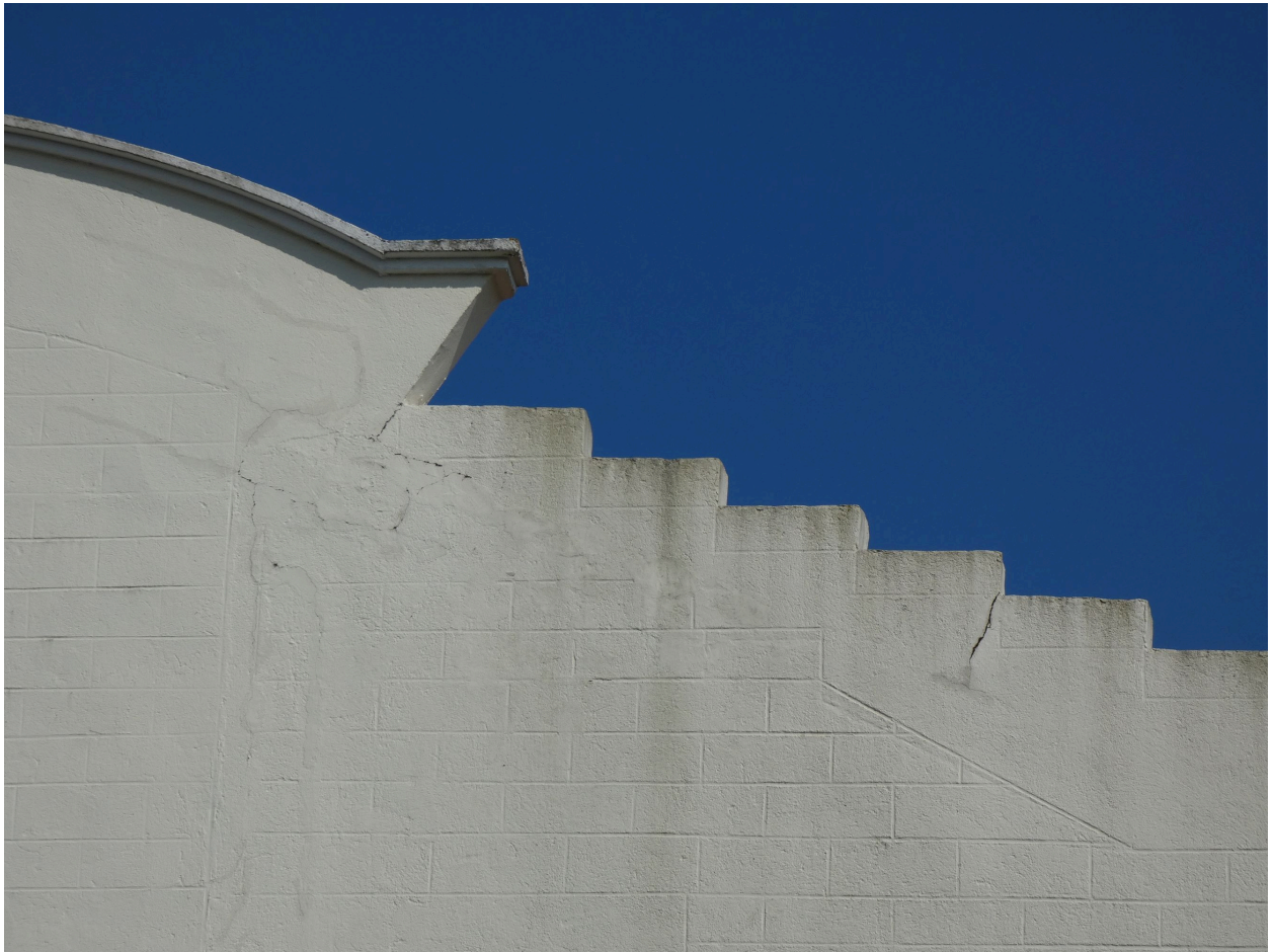
Détail du mur pignon ouest et de son fronton.
